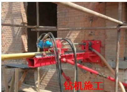
(a) 钻机穿墙施工
