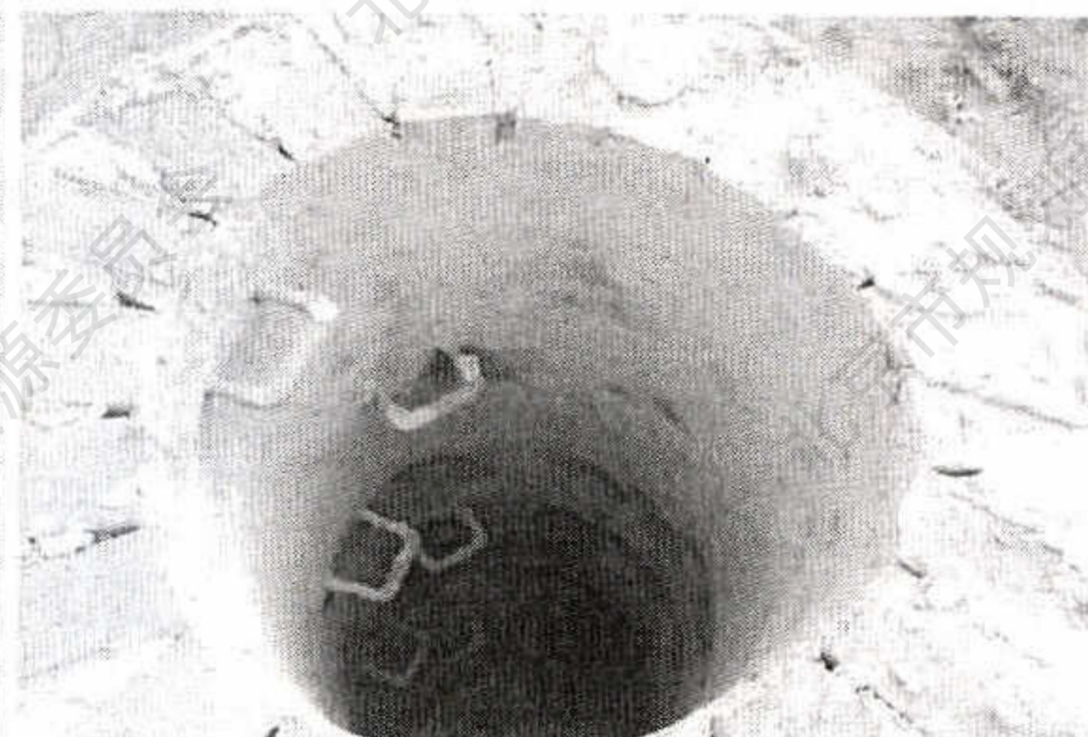
项目内不明用途井
