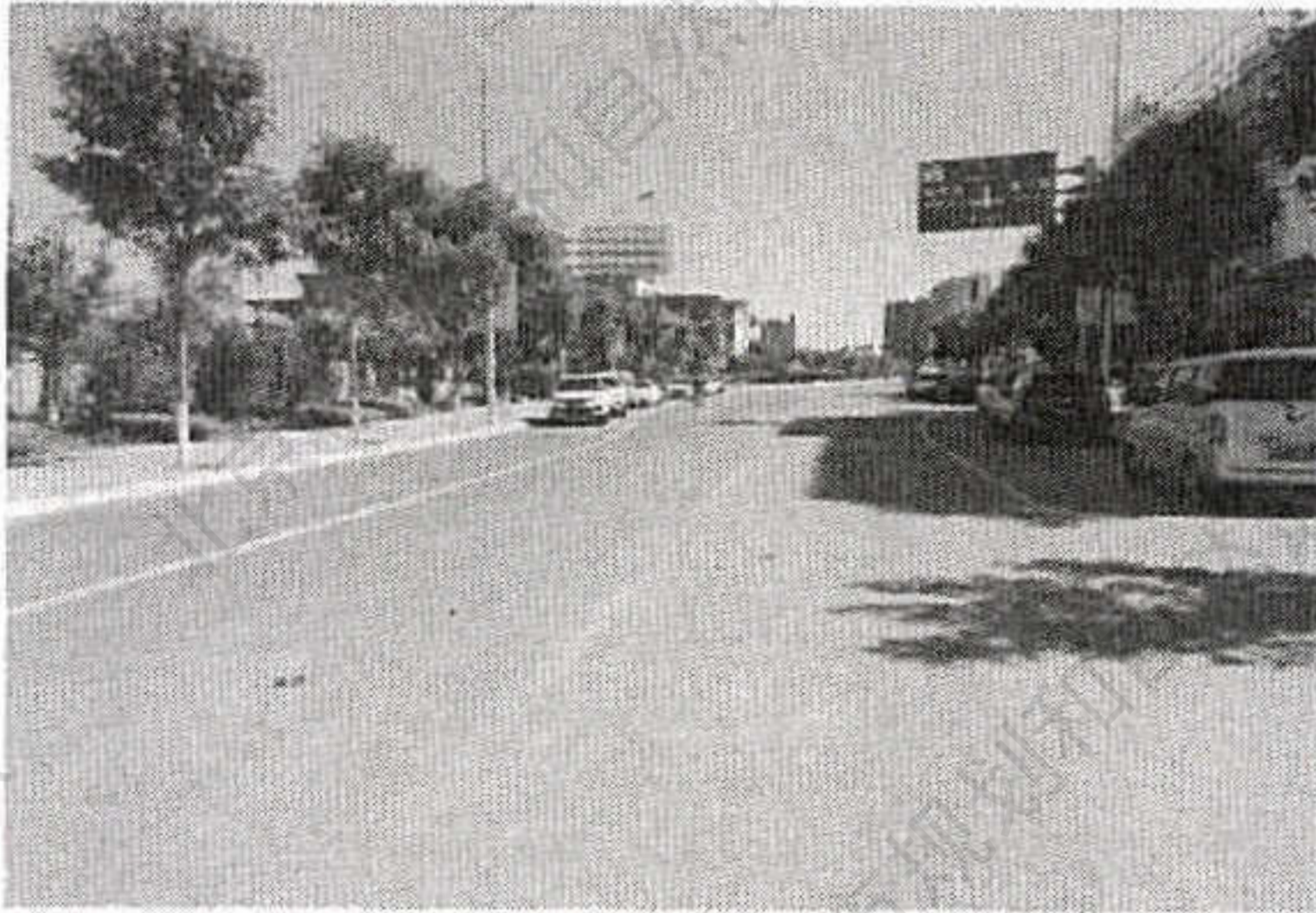
项目西侧现状道路
