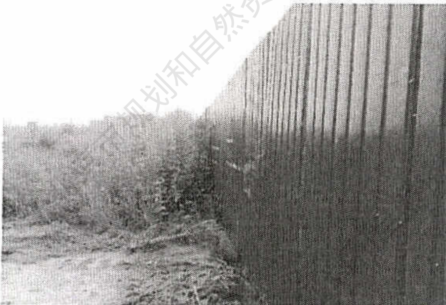
项目西侧围挡
