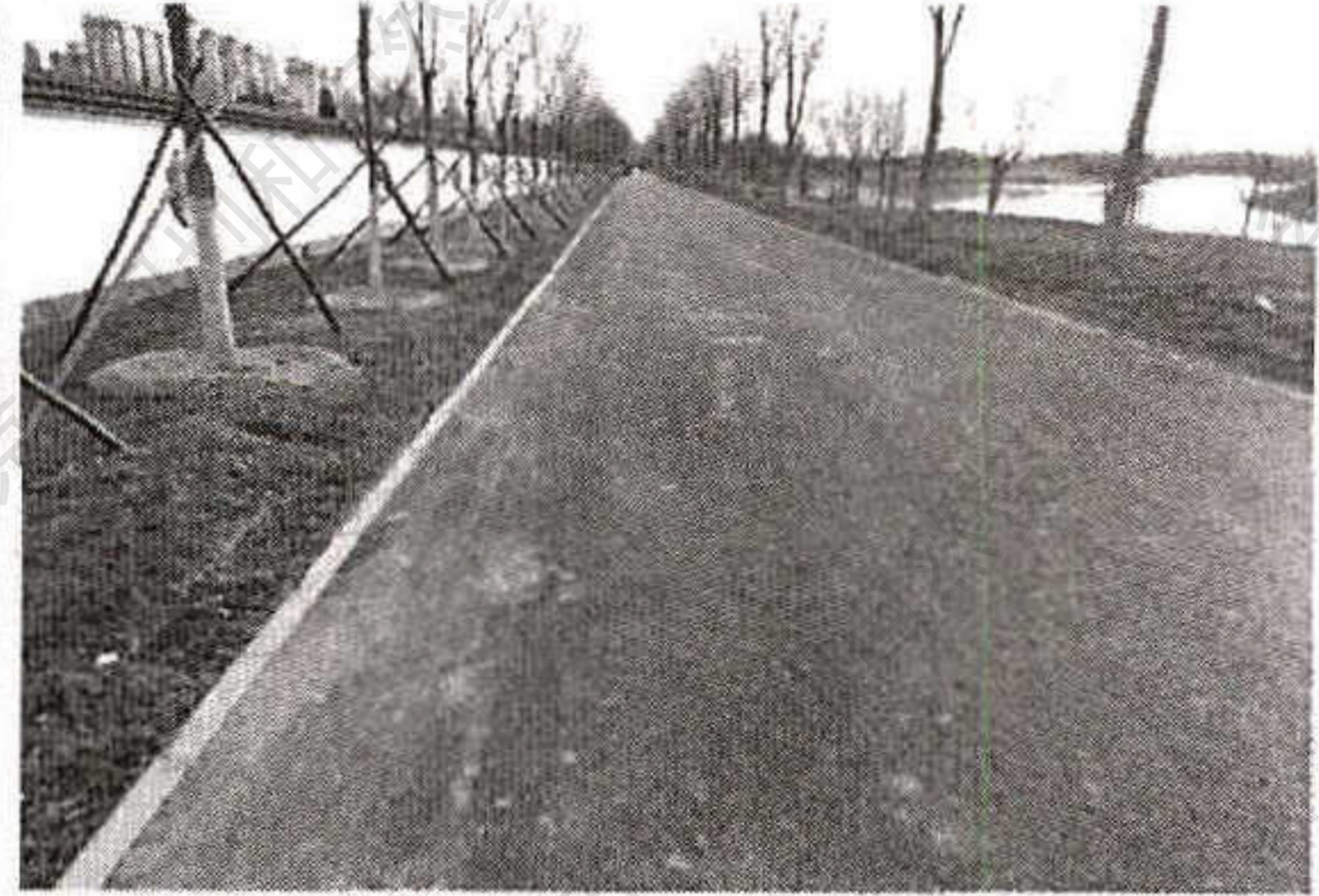
项目南侧现状道路
