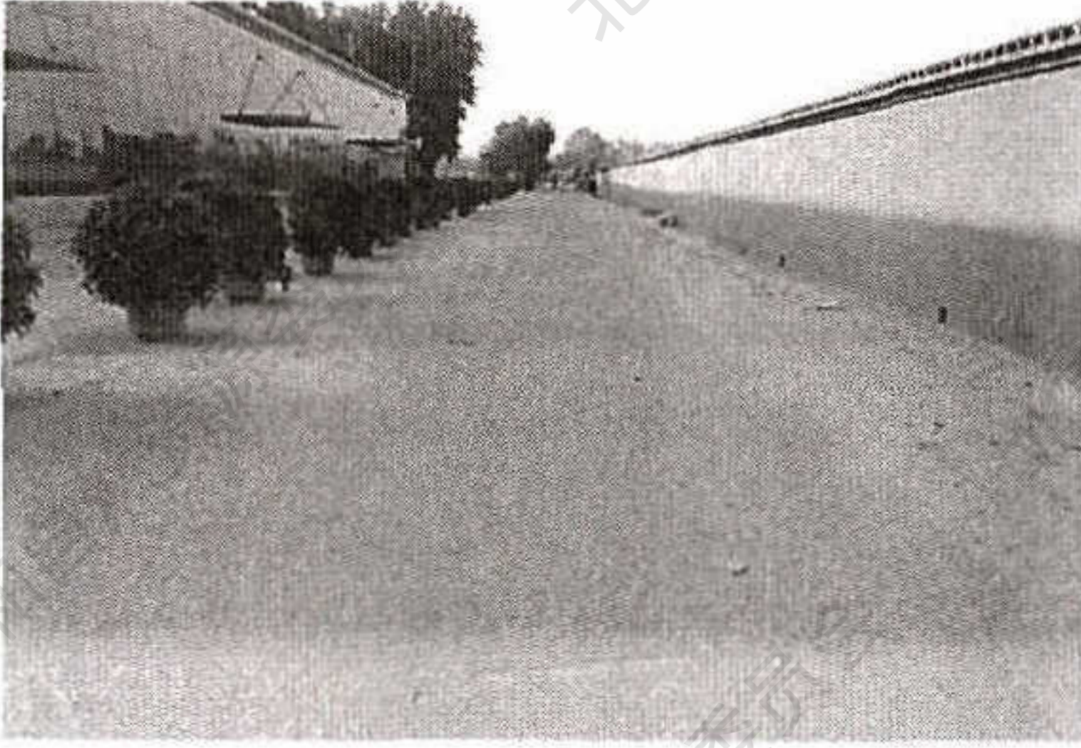
项目东侧现状道路
