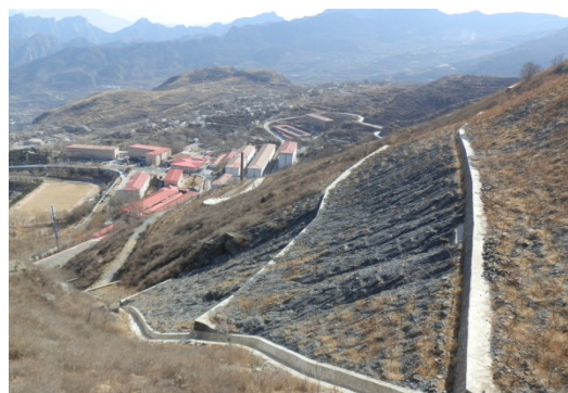
照片 2-7 +1050 恢复治理后图
