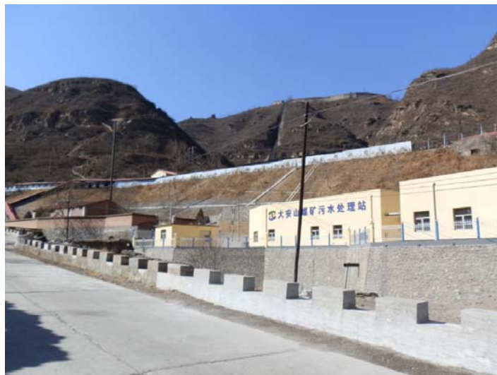
照片 2-8 大安山煤矿污水处理站
