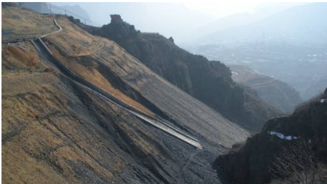
照片 3-5 前台咀煤矸石坡面
