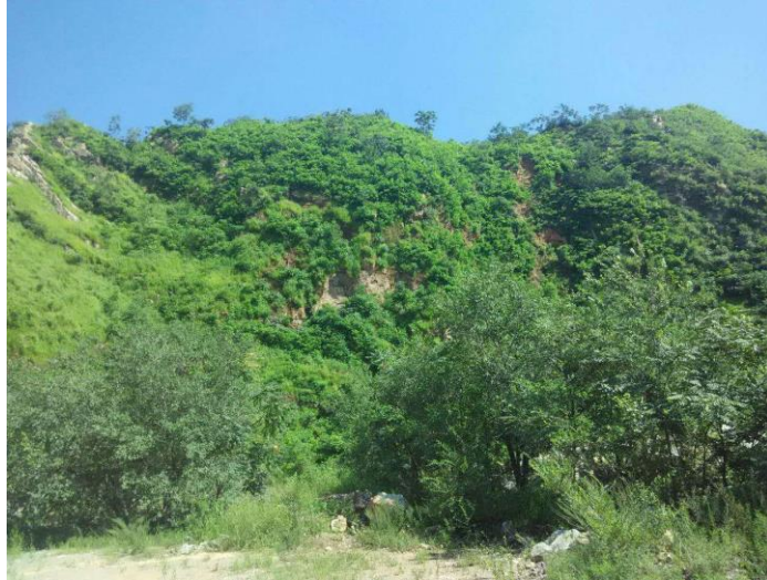
影像 2-5 治理后（采面挂网喷播绿化效果）
