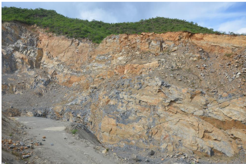
影像 3-3 下庄矿段北侧终采边坡坡面现状
