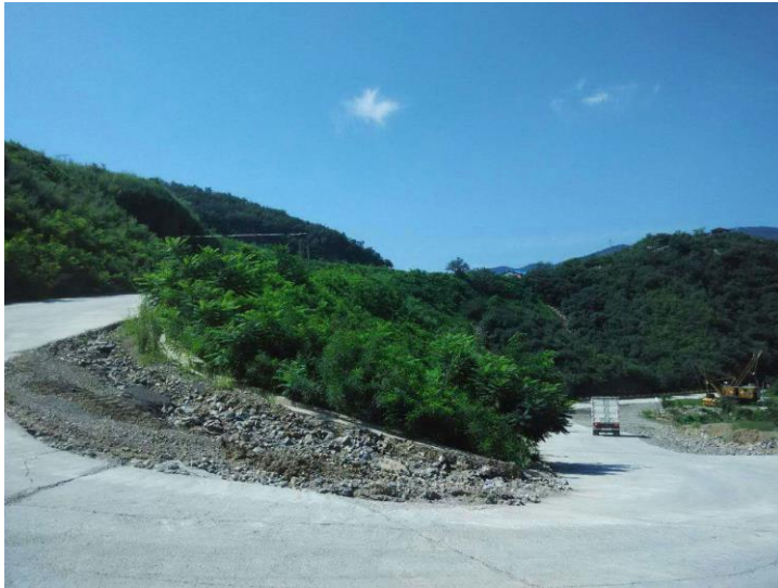
影像 2-8 治理后（渣坡挂网喷播绿化效果）
