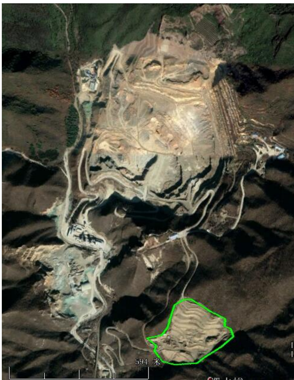
影像 2-8 正在实施的排土场关闭工程治理范围（绿线圈定）
