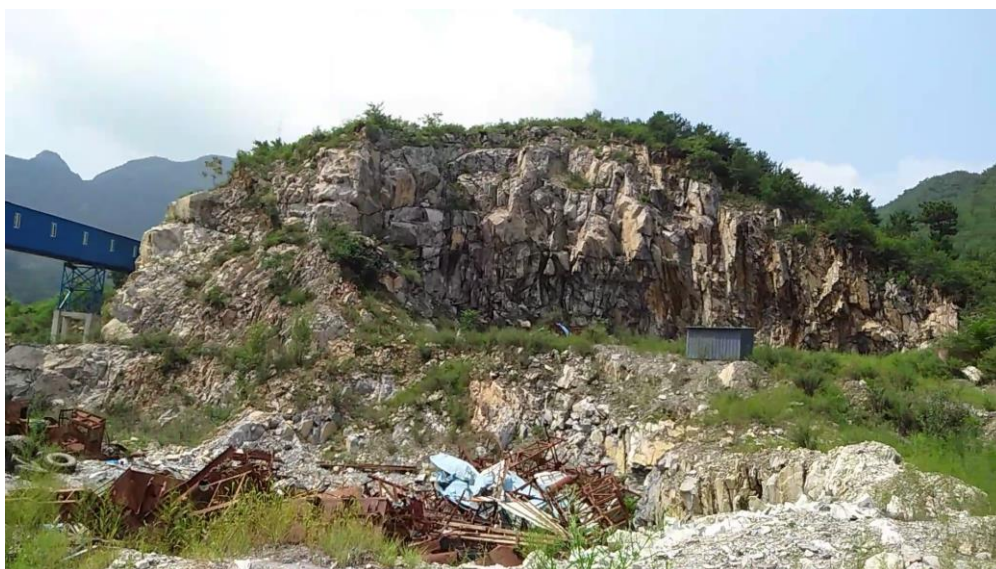
影像 5-10 治理区现状
