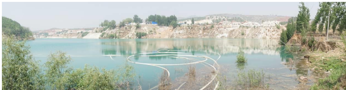
照片 3-4 采场内涌出的地下水
