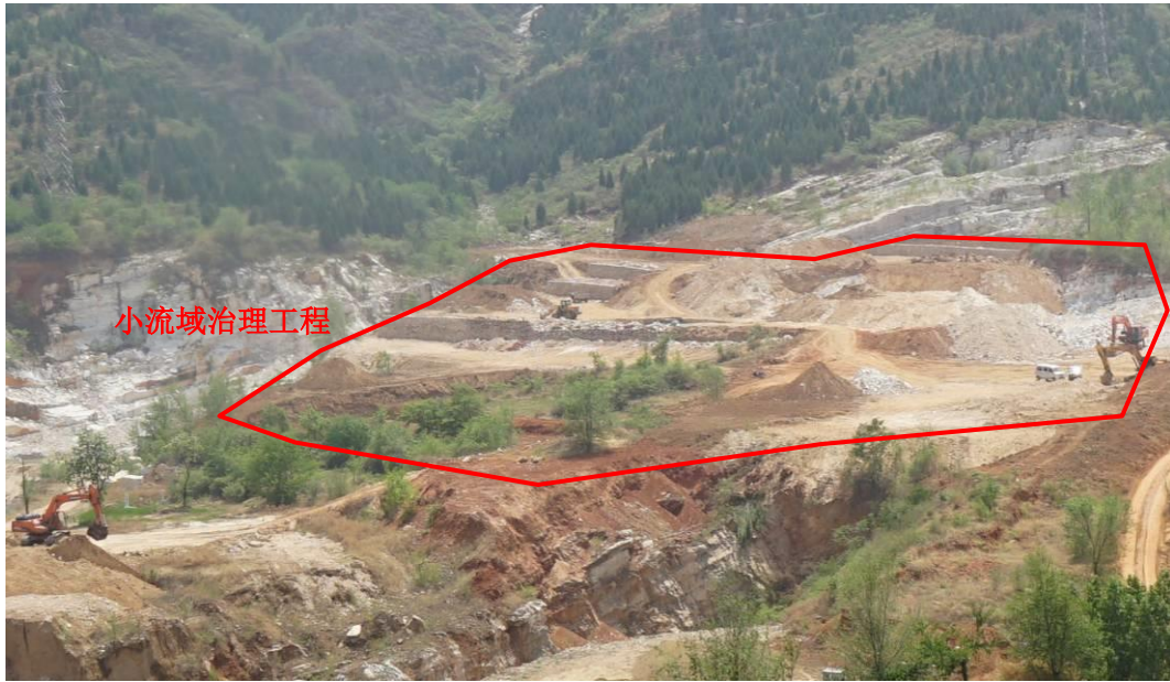
照片 2-6 矿区西侧小流域治理工程
