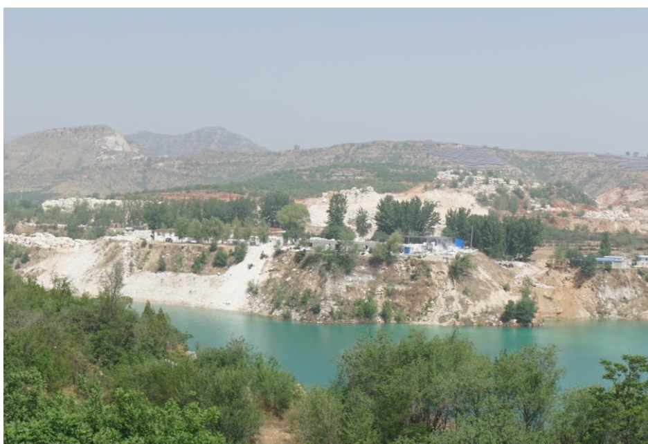
照片 3-8 5号渣坡（镜像北西）
