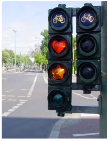
【丹麦自行车绿波】 为了突出对骑行者的友好，丹麦哥本哈根的许多路口推行独立的自行车信号灯，并给予至少4秒的信号优先；同时，部分自行车流量大的道路还设有自行车计数器，以便骑行者更好地规划路线，避免自行车拥堵。目前，哥本哈根自行车绿波2.0版也正在测试，它甚至能记录自行车车队的传感器，当车队接近交叉口时，绿灯时间会自动进行动态延长或调整。
