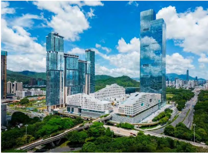
【深圳市福田区深业上城UpperHills项目】
