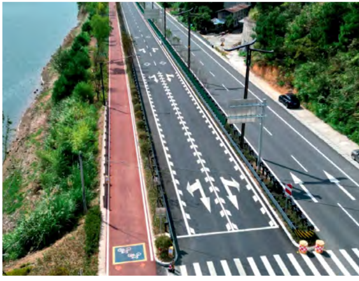
【杭州市淳安县千岛湖环湖公路慢行交通系统】
