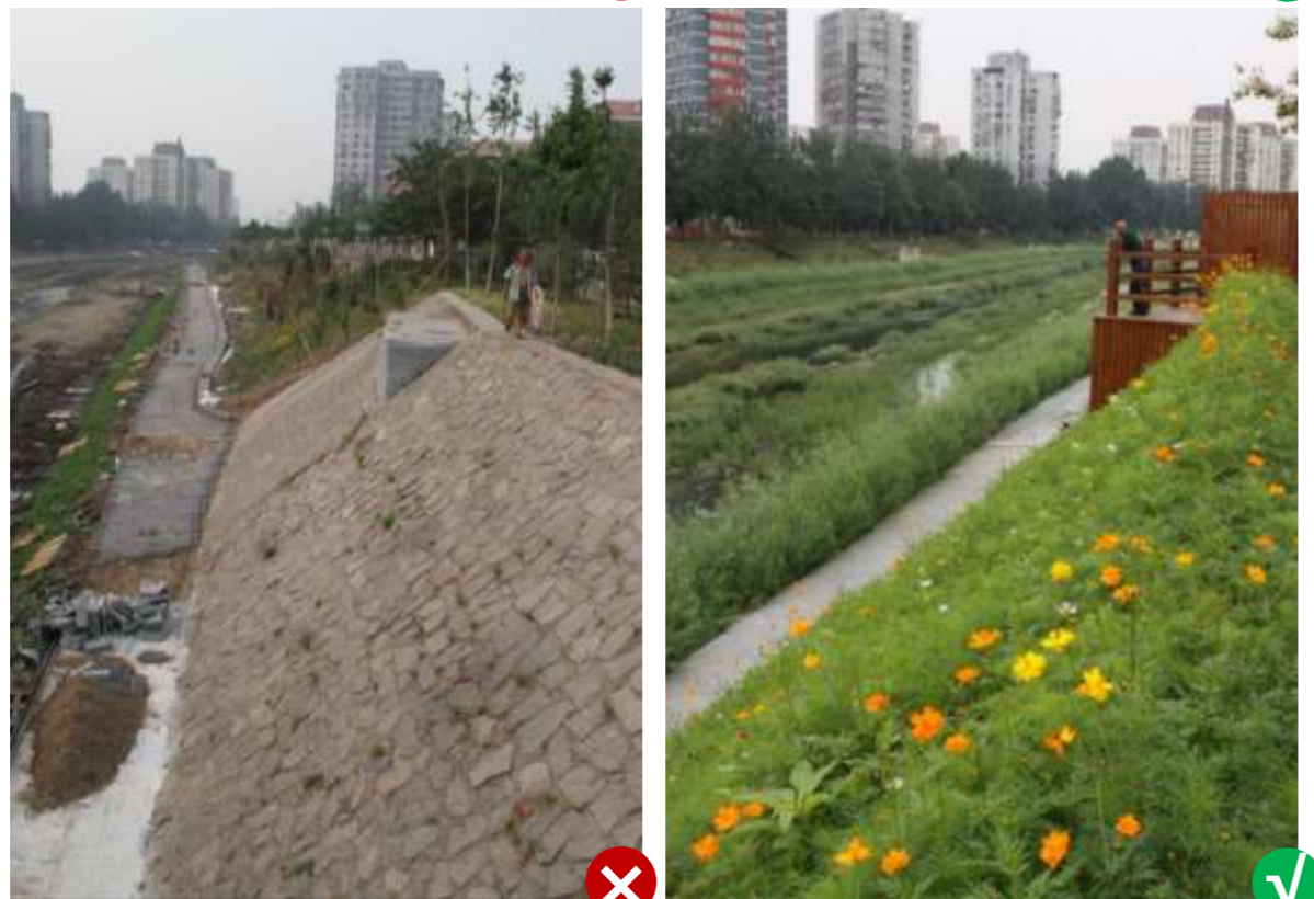
浆砌石护坡改造前
