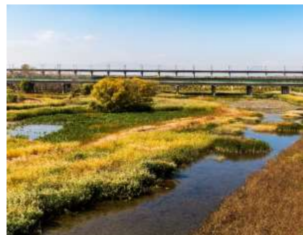
永定河平原非建设区段（图片为课题组拍摄）
