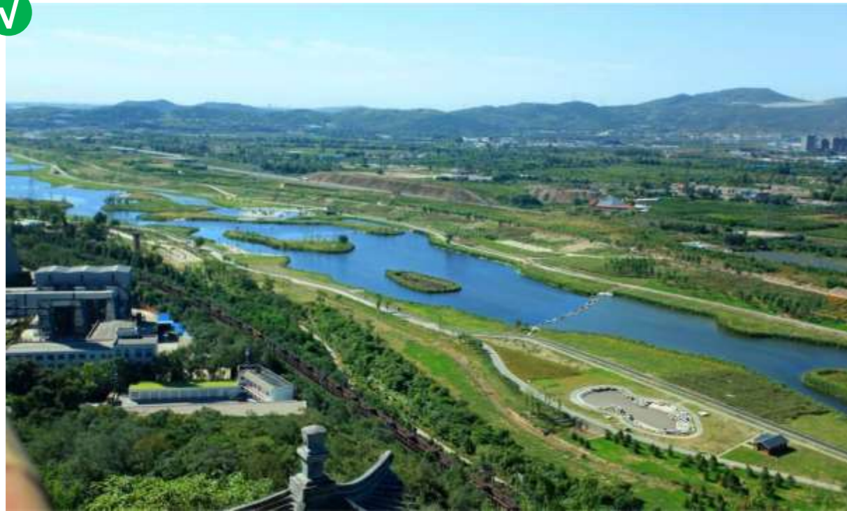
永定河综合治理工程（图片来自微信公众号“邓工说水”）
