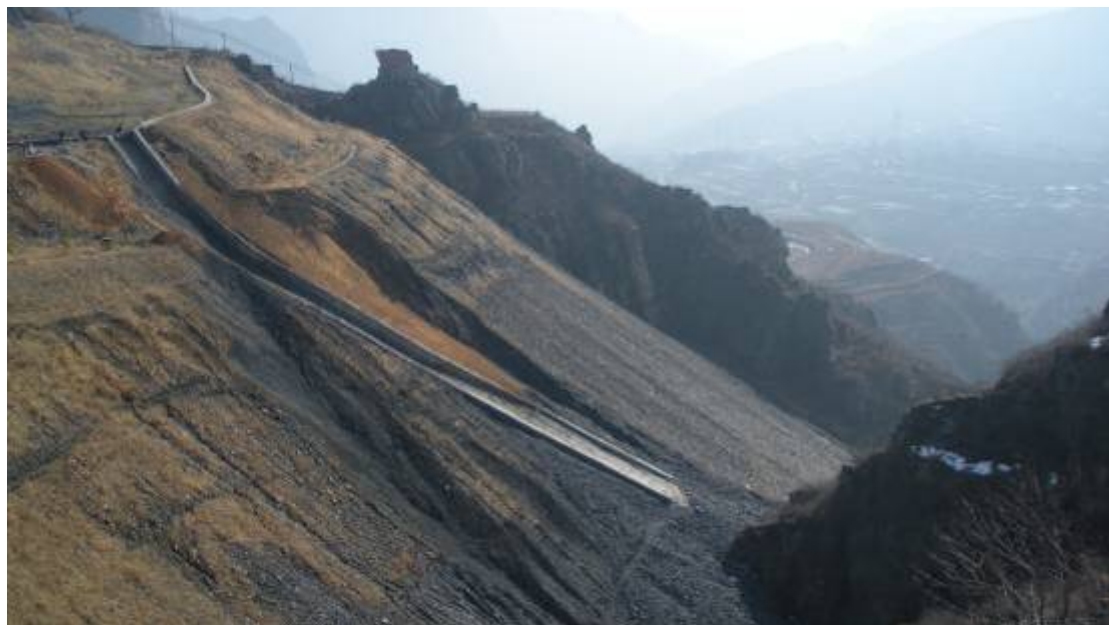
照片 3-5 前台咀煤矸石坡面
