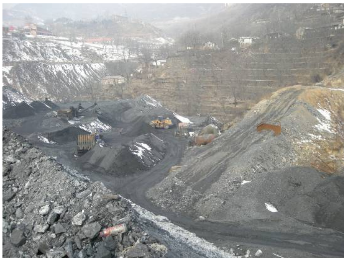
照片 3-6 +800m 水平煤矸石平台矸石堆
