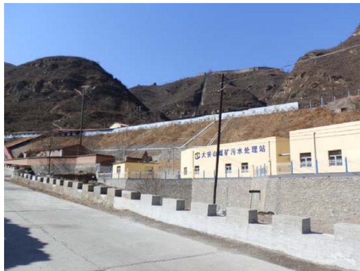
照片 2-8 大安山煤矿污水处理站
