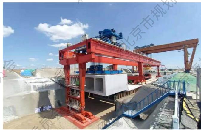
雄安新区长节段、大吨位整体预制装配
