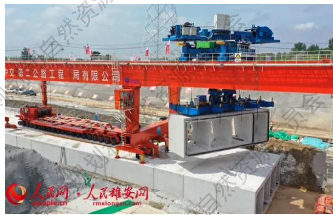
雄安新区长节段、大吨位整体预制装配
