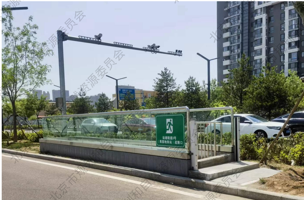
运通隧道疏散通道，采用敞口式设计
