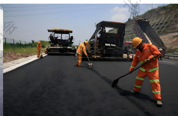
常规热沥青与温拌沥青路面施工
