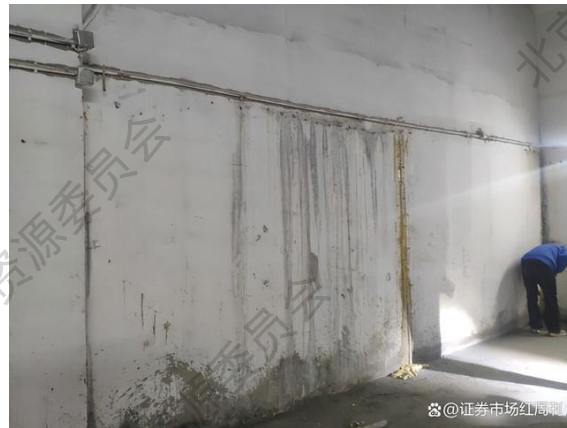
施工缝漏水
