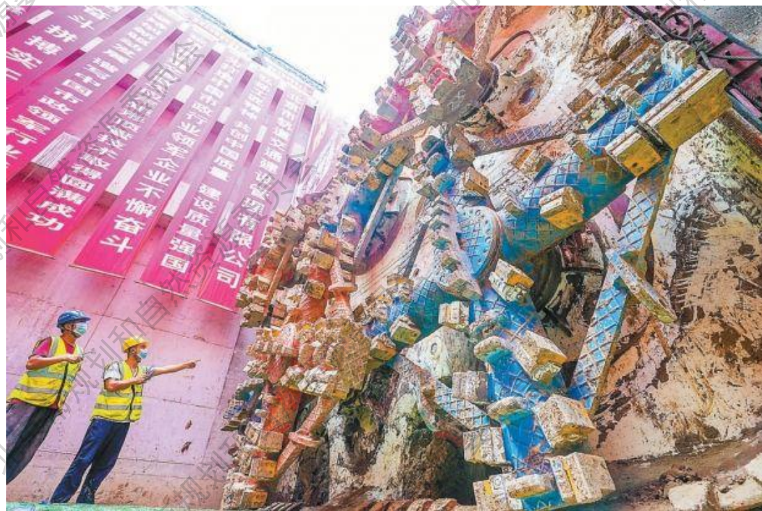
地铁昌平线南延顶管法施工
