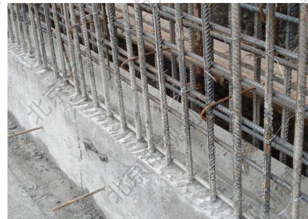
施工中的施工缝
