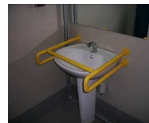
图9 无障碍洗手台参考图
