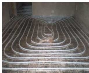
图12 地板采暖系统管路铺设
