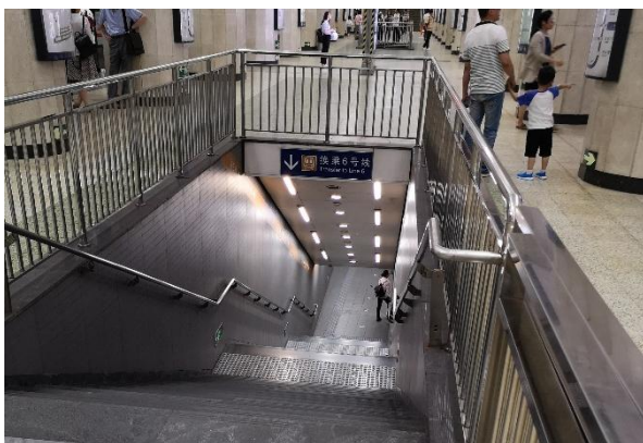
楼梯布局未统一
