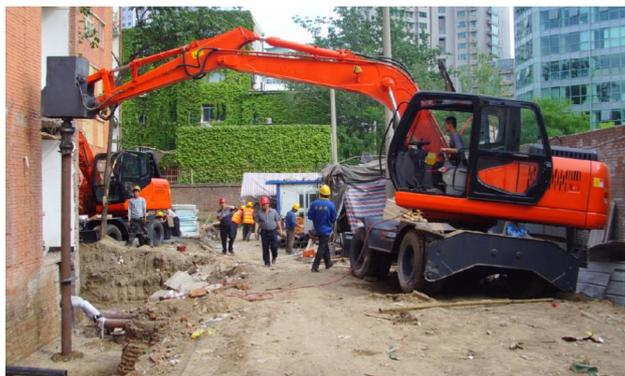
图 4.4.3-2 旋转钻进复合钢桩施工机械
