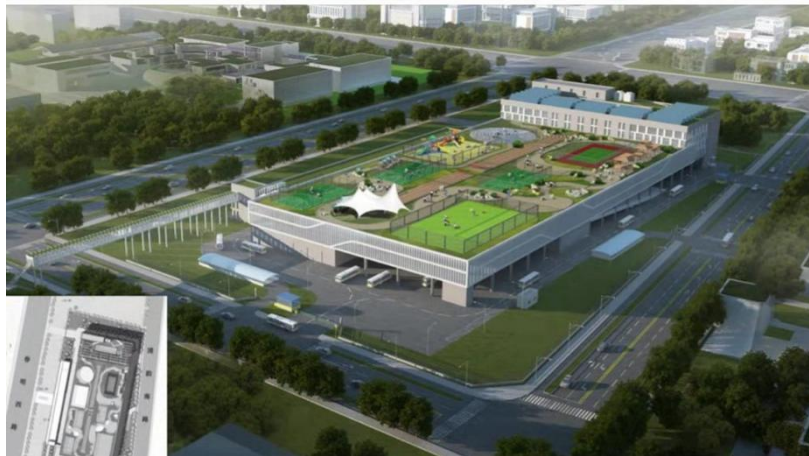
图2.2 兼容类公交场站案例：北京东小营中心站 (兼容体育设施、小型商业服务及社会停车场)
