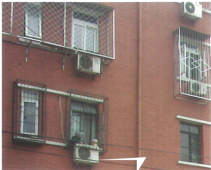
改造前窗户现场照片
