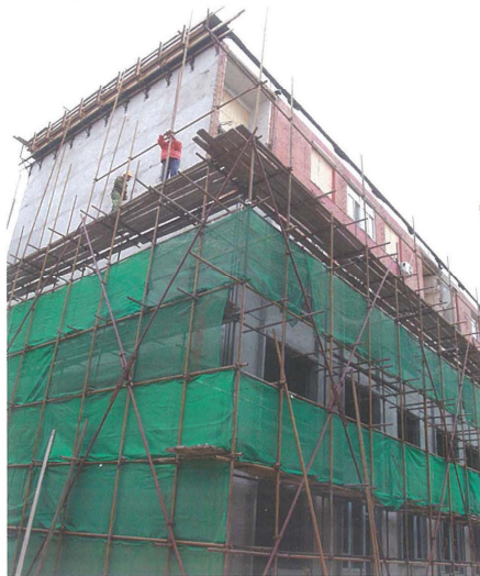
改造中南立面
