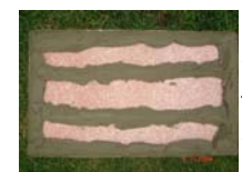
防火隔离带应采用条粘或框条粘
