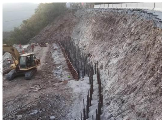
图 4.2.7-3 微型桩挡土墙示意
