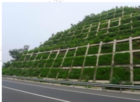
图 4.3.6-1 锚杆（索）框架植被防护
