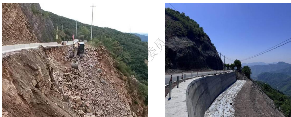
图 4.2.7-6 陡坡路基水毁重建实施情况
