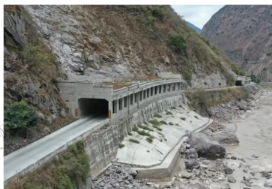
图 3.5.3-2 棚洞式隧道型式
