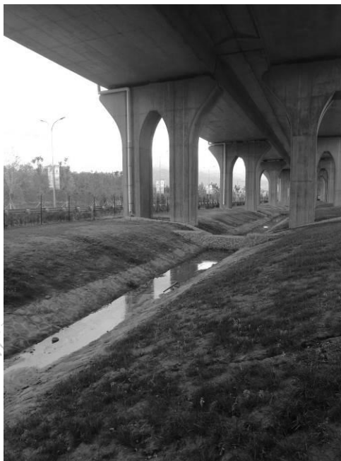
图 6.4.1-2 高速公路高架桥下雨水滞蓄塘
