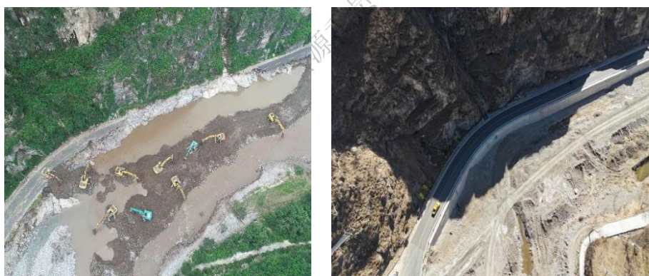
图 4.2.6-7 临河路基水毁重建实施情况
