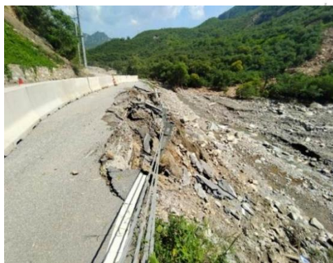
图 4.2.7-4 沿河公路受洪水冲刷造成路基边坡垮塌
