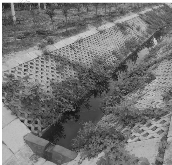
图 6.2.2-2 拦水堰实景照片
