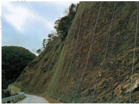
1—上锚杆；2—柔性金属网；3—横向绳；4—坡面；5—下锚杆；
