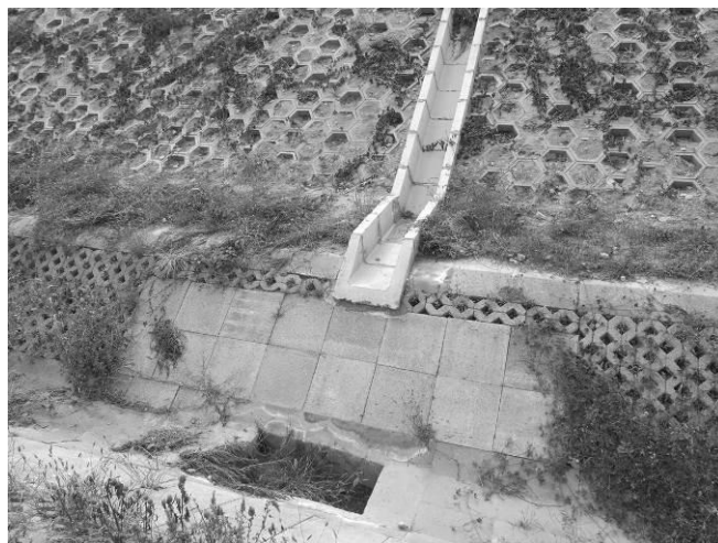
图 6.2.3-2 消力池实景照片
