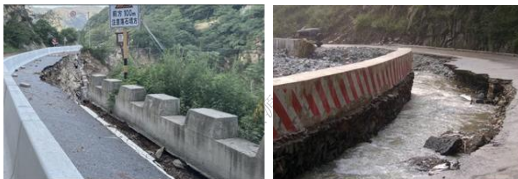
图 4.4.3 墙式护栏阻水造成路肩损坏、路基滑塌
