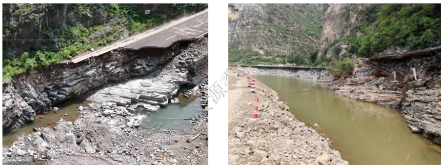
图 4.2.6-4 沿河公路受洪水冲刷造成挡土墙及路基垮塌
