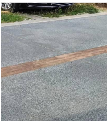
图 5-5 平整的水泥混凝土路面
