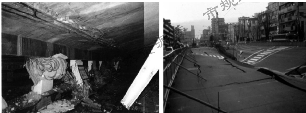
a) 中柱和顶板破坏 b) 地面塌陷
