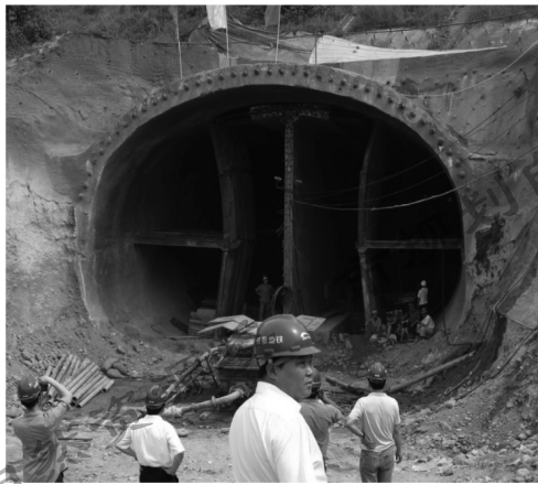
图 3.2.2-20 下穿外环高速的浅埋暗挖隧道
