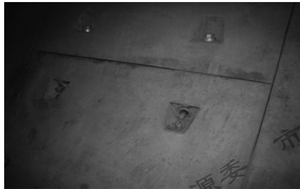
图 3.2.2-18 连接螺栓松动滑落
