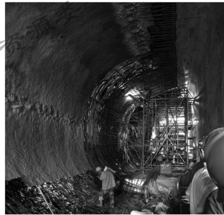
图 3.2.2-21 隧道已完成初支和中隔墙施工
