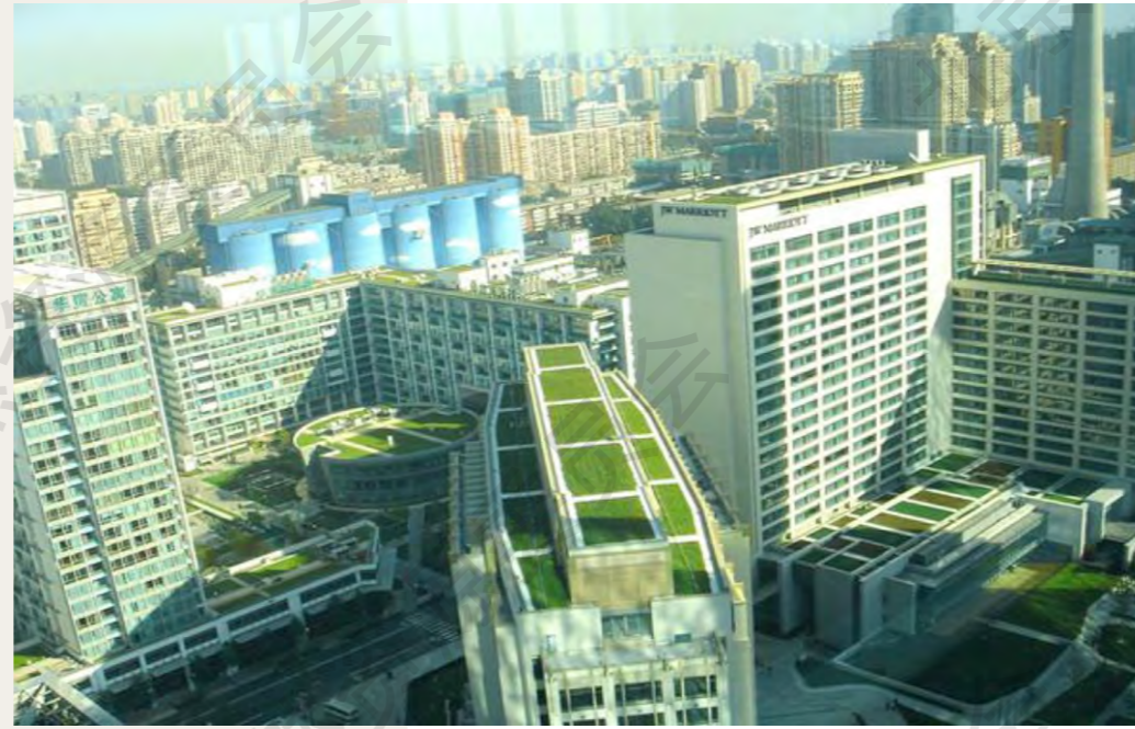
朝阳区华贸中心屋顶草坪
