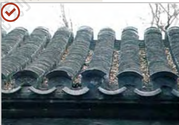
历史建筑、传统风貌建筑屋面采用合瓦
