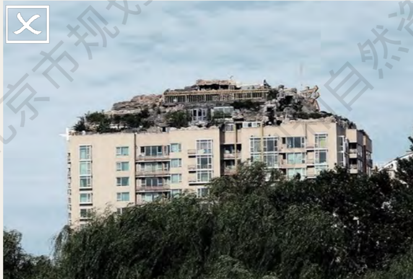
人济山庄屋顶的屋顶违建
