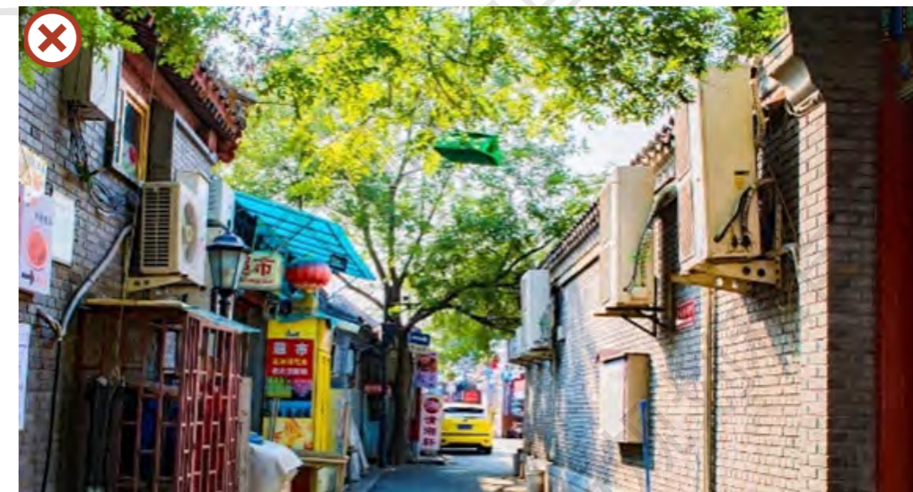
各类建筑外挂设施设置杂乱
