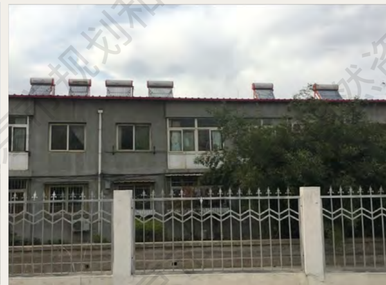
高出女儿墙的屋顶设施
