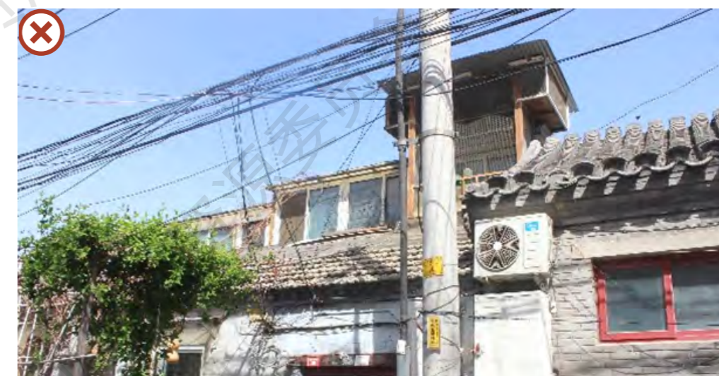
违规加建二层、破坏传统屋顶轮廓
