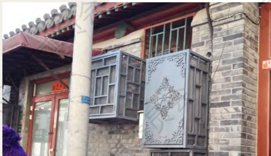
空调室外机、电箱外罩隐蔽处理
