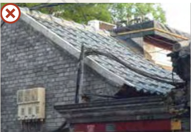
传统风貌建筑屋面采用平机瓦
