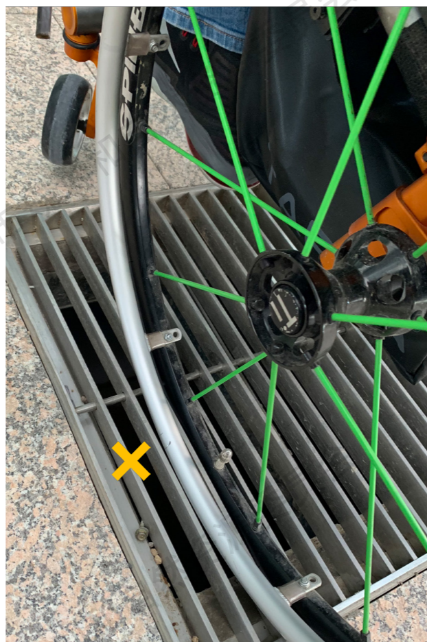
雨水篦子间隙大于 15mm
