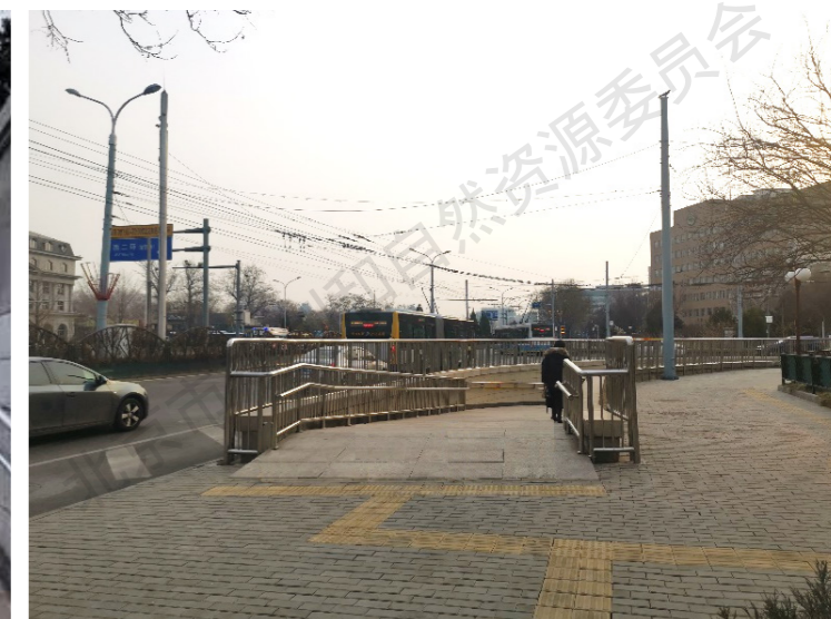
人行地下通道盲道实例图
