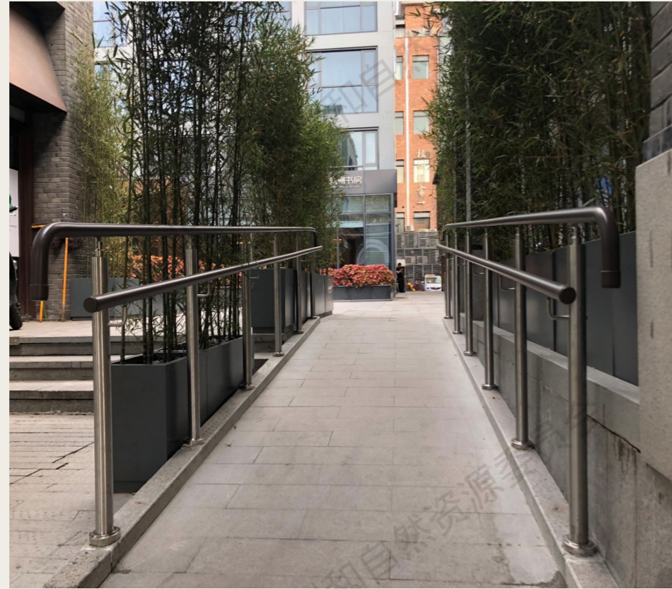
无障碍坡道扶手实例图
