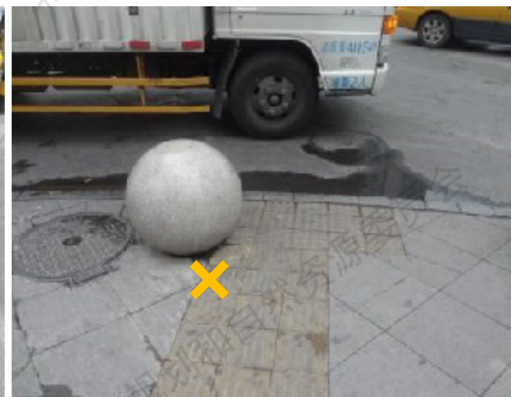
盲道被障碍物占压，通行空间不足
