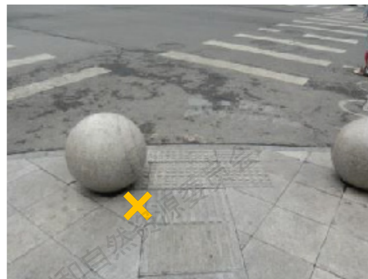
盲道被障碍物占压，通行空间不足；且盲道砖颜色不显著
