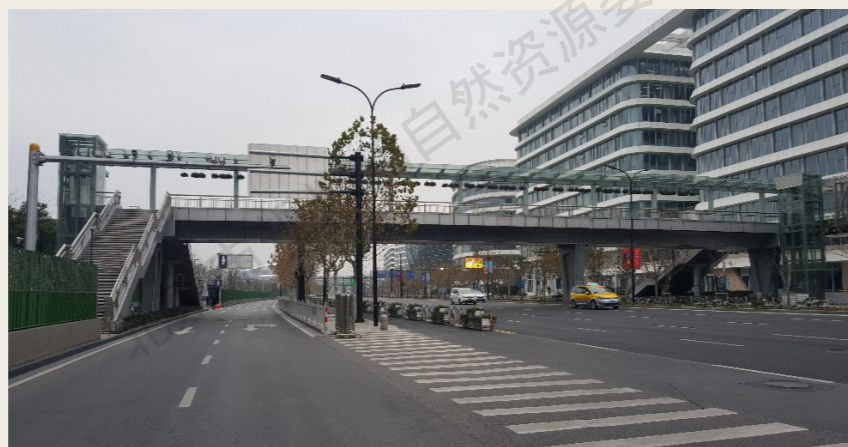
人行天桥电梯实例图
