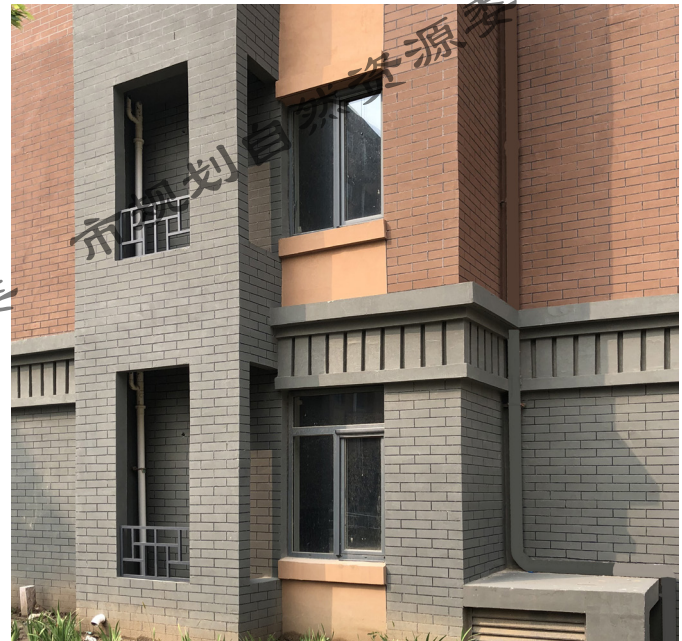
将雨水管粉刷为外墙颜色，存在感明显降低
