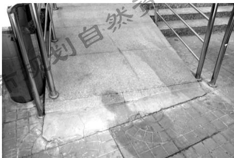
图 6.2.7.1 坡口与地面在施工后存在高差会带来新的障碍
