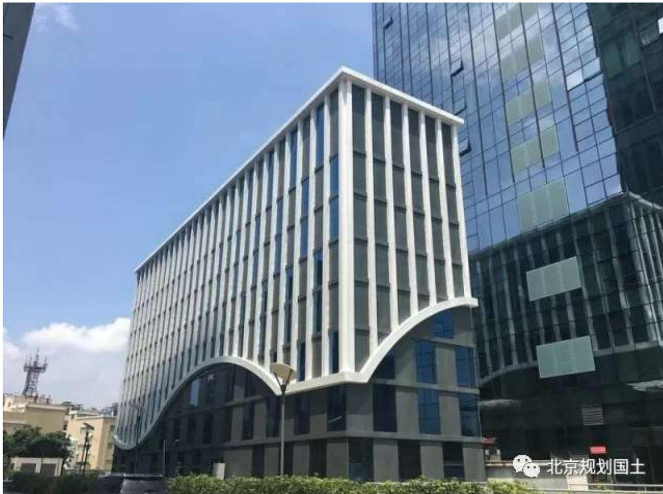
福州恒丰大厦八层梳齿垂直升降立体车库于2017年建成，占地面积240平方米，高8层，可提供88个停车位。独特的冷色系外包装高端大气，使冰冷的钢结构立体车库散发出浓郁的商务气息，完美融入周围建筑群。
