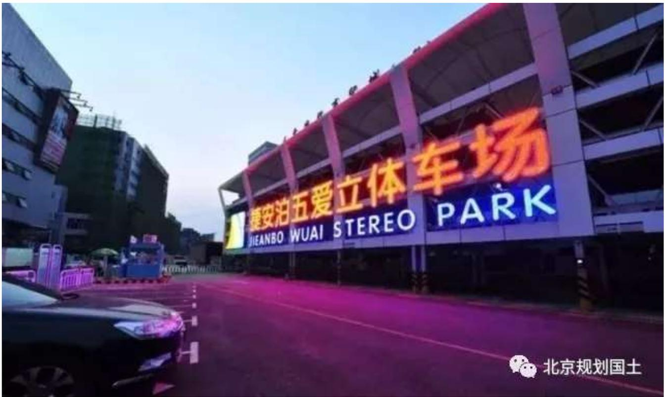
沈阳捷安泊五爱景观化立体停车场于2015年建成，占地面积392平方米，高5层，可提供85个停车位。该停车场在建设时充分考虑到北方气候的因素，合理规避了风压、雪压等影响，能够适应东北地区冬季漫长寒冷的特点，最低温度可适应 - 40℃的低温。
