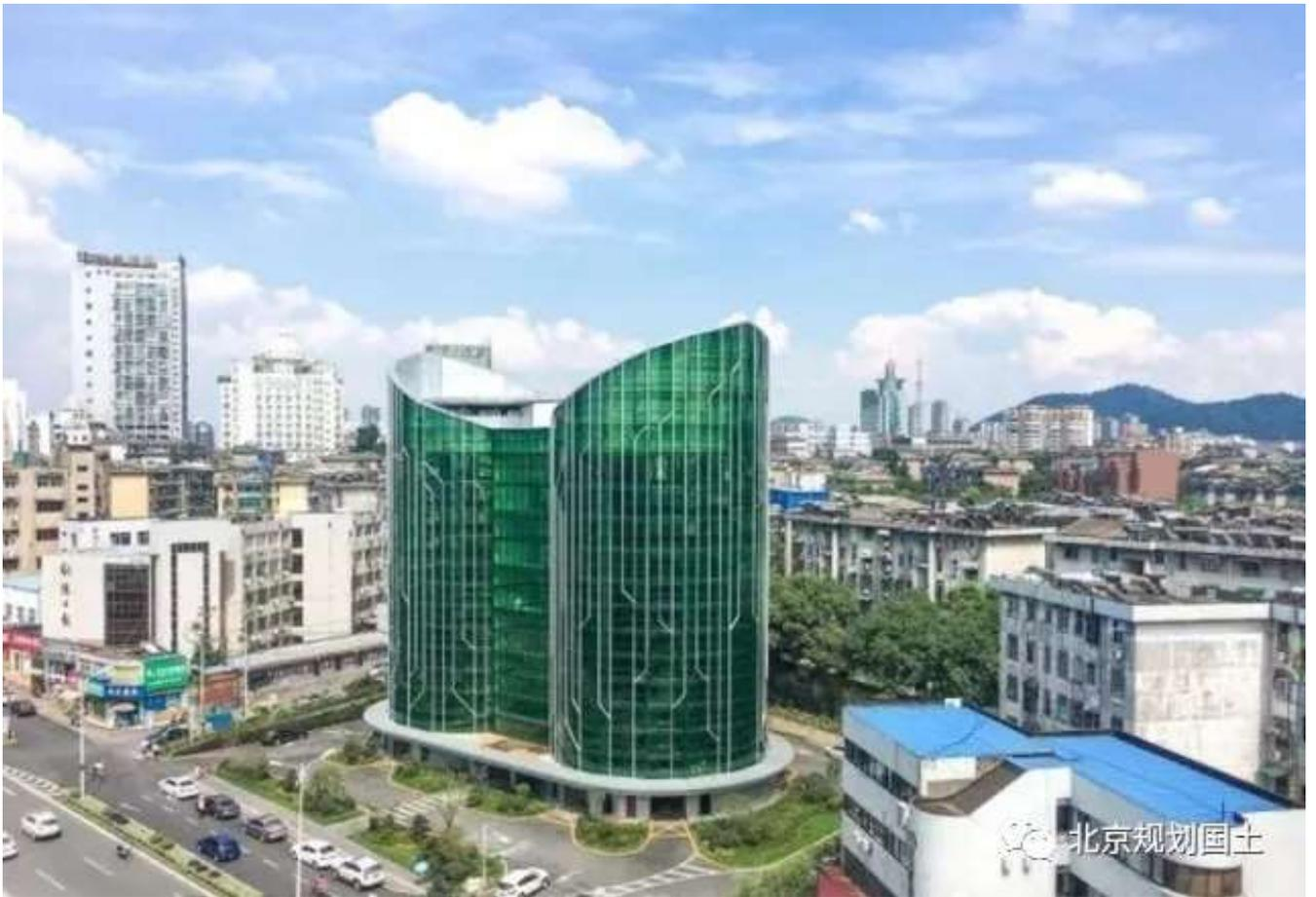
铜陵市淮河路智能立体停车楼于2017年建成，占地面积735平方米，高15层，可提供200个车位。该停车楼采用“全智能化多出入口圆塔式立体库”技术，技术国内领先。
