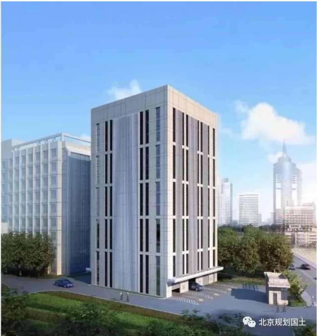
厦门海关总关立体停车楼于2016年建成，占地面积400平方米，高15层，可提供168个停车位。该停车楼采用先进的全自动新型垂直升降类停车设备。
