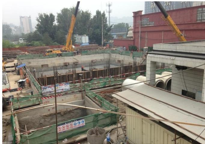
和平里项目进水管顶管施工
