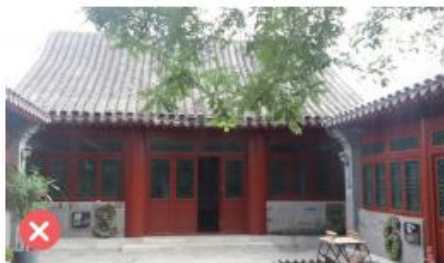
建筑物高度过高、体量过大
