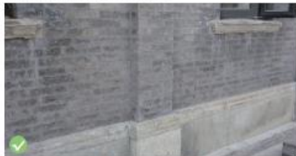
通过清洗、修补等方式进行墙体修缮，恢复外观
