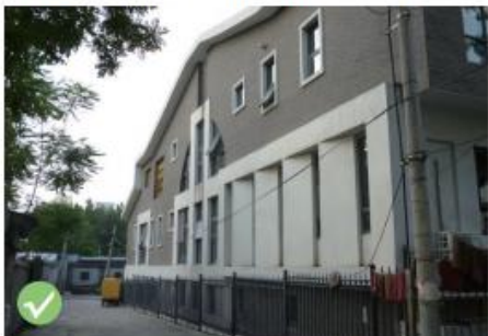
建筑更新中的建筑外立面色彩控制 ▶
