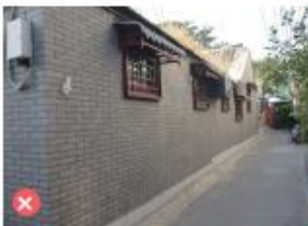
墙体采用仿古砖贴面
