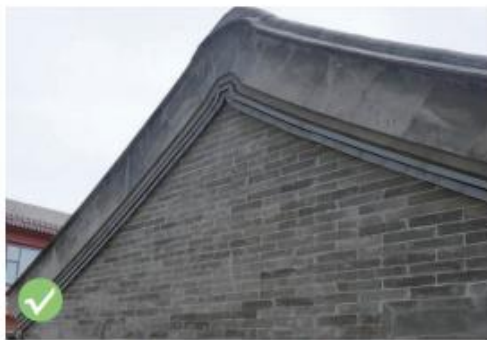
管线在隐蔽部位线槽敷设
