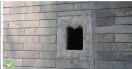
通过打磨方式进行墙体修缮，恢复外观
