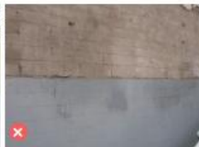
墙体采用抹青灰刻假缝
