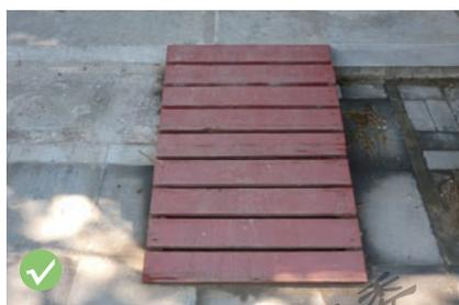
可移动、可拆卸式无障碍坡道
