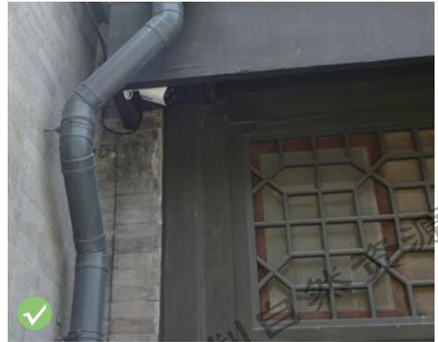
建筑外部雨水管置于隐蔽处，且采用具有隐蔽效果的样式、色彩、材料
