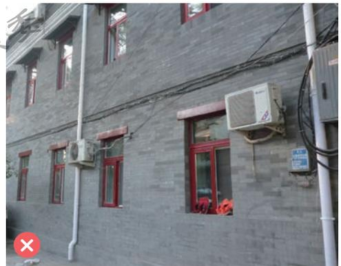
建筑外部雨水管无序设置、明显突兀，影响街区传统风貌
